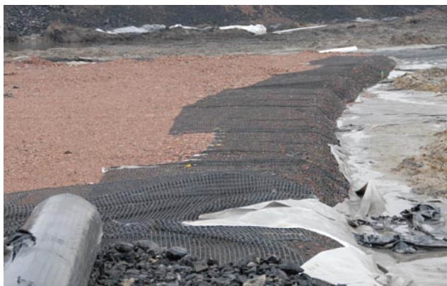
Fot. 1. Materac z czerwonego (przepalonego) łupka – łącznica Z-1
