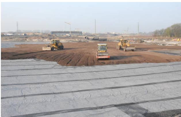
Fot. 5. Budowa materaca na wzmocnionym podłożu ciąg A1 przy WD 464
