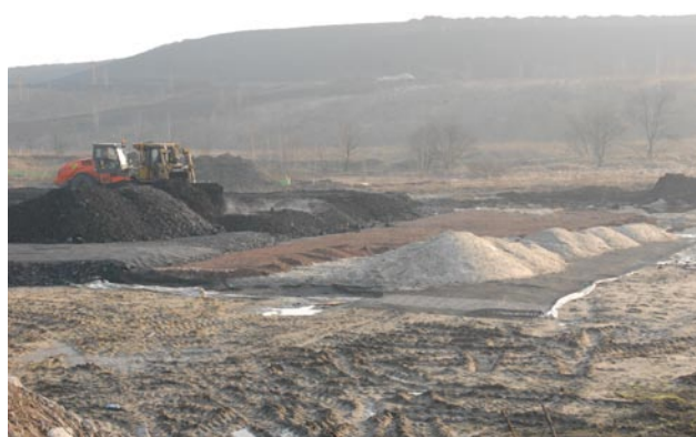
Fot. 8. Budowa nasypu z czarnego łupka na ciągu A1, widoczne poszczególne warstwy
