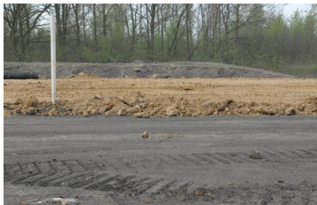
Fot. 6. Budowa przekładki gruntowej nasypu z czarnego łupka na łącznicy G-1
