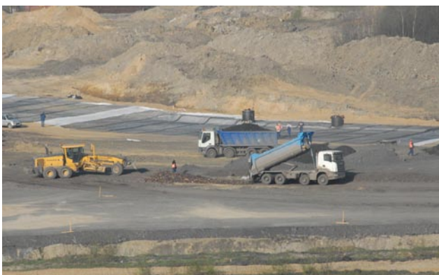
Fot. 7. Budowa materaca na łącznicy G-2. Blżej łącznica G-1
