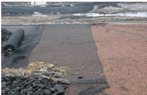
Fot. 2. Warstwa nasypu na materacu z czarnego łupka
