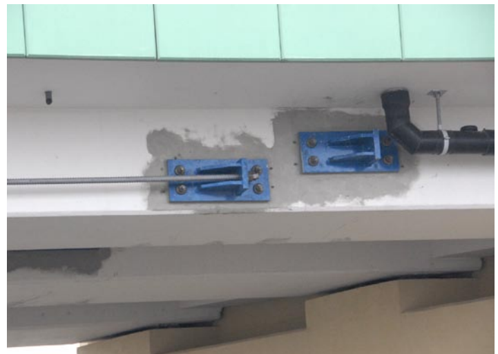
Fot. 2. Szczegóły bloków kotwiących cięgna sprężone
