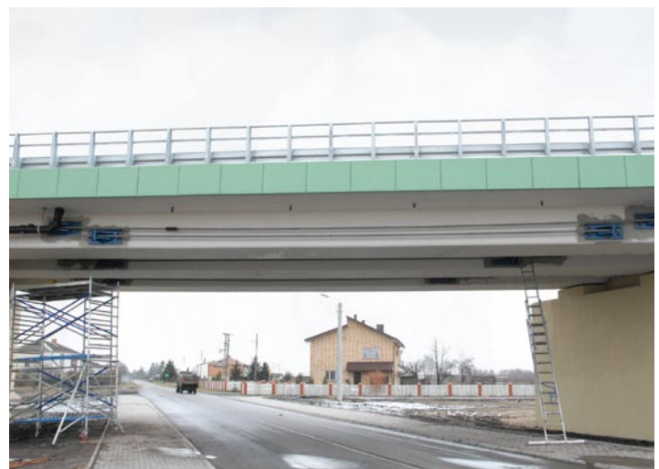
Fot. 3. Cięgna prętów stalowych na zewnętrznej stronie belki zewnętrznej
