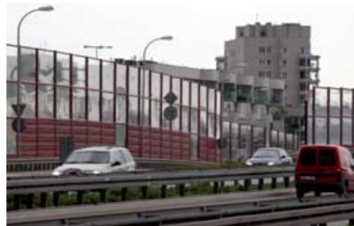
Ryc. 4 Ekran ochrony akustycznej na trasie w Warszawie (fot. autor)
