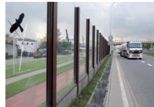
Ryc. 3 Ekran ochrony akustycznej na trasie w Warszawie (fot. autor)
