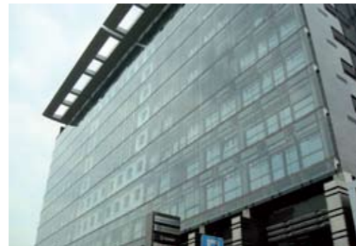
Ryc. 2 Ekran ochronny na budynku Focus w Warszawie (fot. autor)
