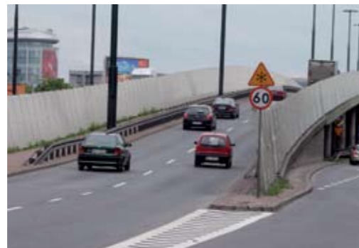
Ryc.1 Ekran na obiekcie inżynierskim w Warszawie (fot. autor)
