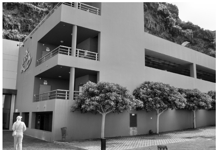
Fot. 4. Szczytowa część wielopoziomowego parkingu nadziemno podziemnego w Caletha na Maderze. (fot. autor)
