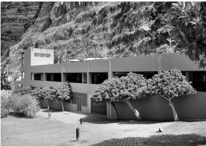
Fot. 2. Szyby wentylacyjne wielopoziomowego parkingu nadziemno podziemnego w jego części środkowej w Caletha na Maderze. (fot. autor)
