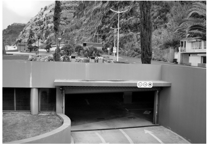
Fot. 3. Naziemna część wielopoziomowego parkingu nadziemno podziemnego w Caletha na Maderze. (fot. autor)
