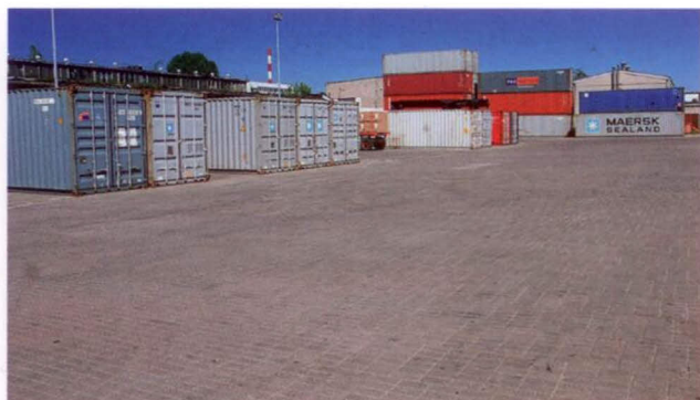
Fot. 1. Nawierzchnia z kostki betonowej na równi placu kontenerowego
