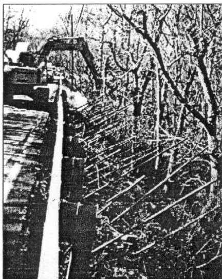
Fot. 5. SNL na podwoziu koparki podczas pracy na „czynnym” osuwisku skarpy drogi.
