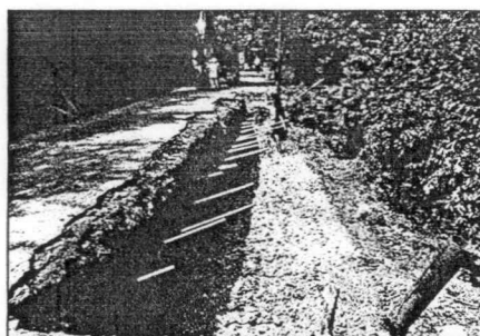
Fot. 3. Lance gruntowe przygotowane do wiązania oczepowego.
