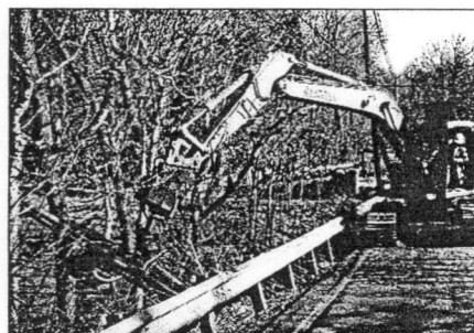
Fot. 7. Wstrzeliwanie gwoździ w czoło skarpy osuwiskowej.
