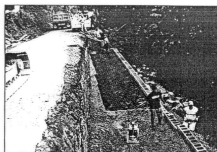
Fot. 4. Wzmacnianie geosyntetykami „zasypek” odbudowywanego muru.
