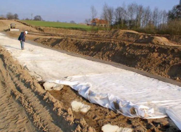
Fot. 1. Geowłóknina w poddożu lub podtorzu, na niwelecie budowlanej, w podłożu nawierzchni drogowej lub szynowej, w układzie planarnym [8]
