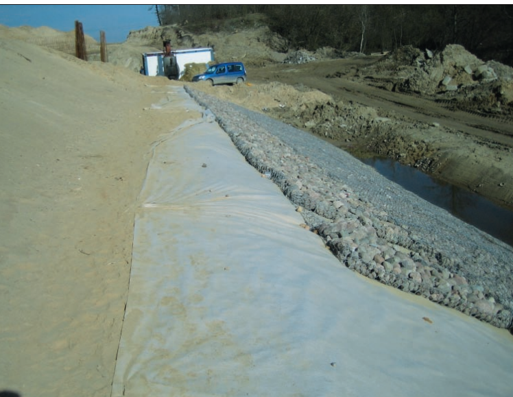
Fot. 2. Separacyjna funkcja geowłókniny o trudnym uzasadnieniu; fot. autor
