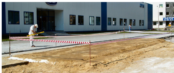
Rys. 5.9. Widok z prawego narożnika poligonowego poletka pomiarowego
