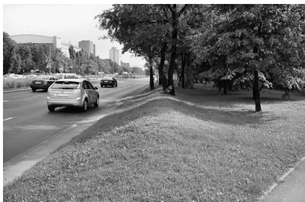
Fot. 3. Nasyp z pokrywa trawiastą (fot. autor)
