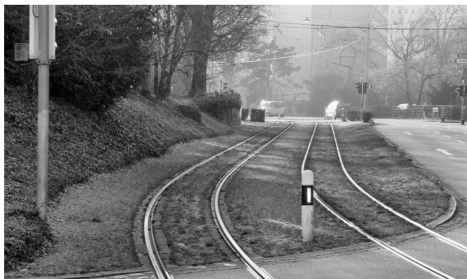
Fot. 4. Wytlumienie nawierzchni tramwajowej pokryciem trawy w Bazylei (fot. autor)
