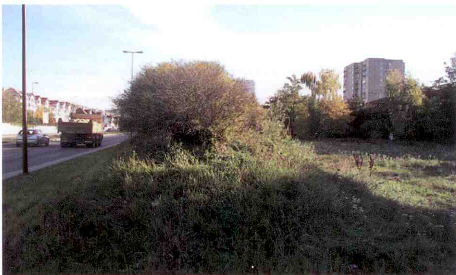
2. Przykład ziemnego ekranu akustycznego z krzewami
