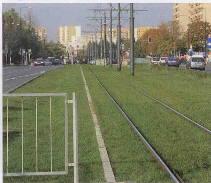
16. Trawnik częściowego wytłumienia torowiska tramwajowego
